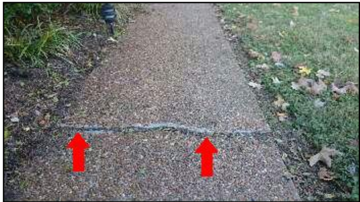
9. Uneven (trip hazard)
