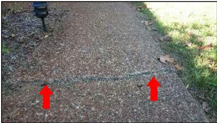
8. Uneven (trip hazard)
