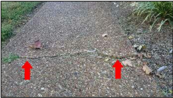
10. Uneven (trip hazard)
